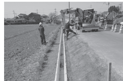
「用水路の復元工事」このとり福祉会が整備した6m道路は計画取り下げのため福祉会負担で復元することになった。本年4月12日撮影
